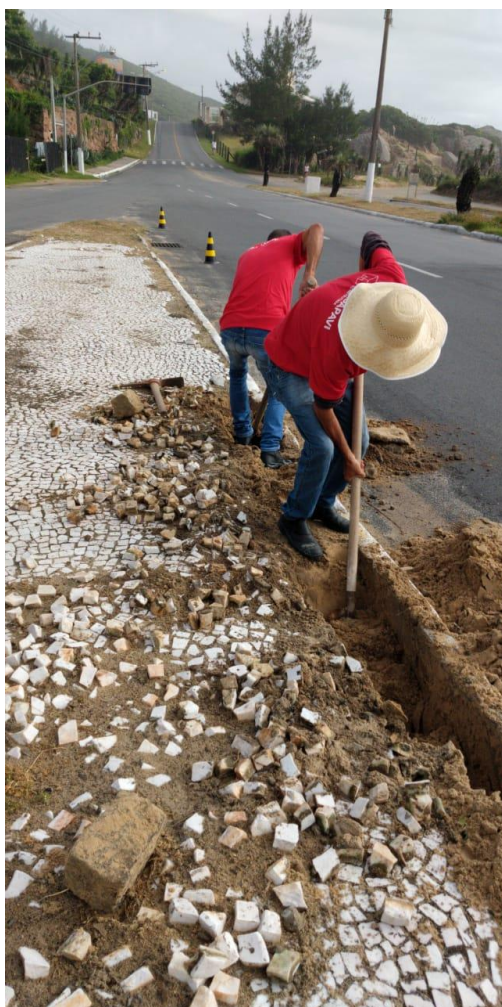
Fig. 6 Processo de restauro de Fronteira, Fonte, Foz (2001), iniciado em fevereiro de 2019. Fonte: site oficial da Prefeitura do Município de Laguna. URL: https://www.laguna.sc.gov.br/noticias/index/ver/codMapaltem/16507/codNoticia/536778 . Acesso em 29 de junho de 2019.
