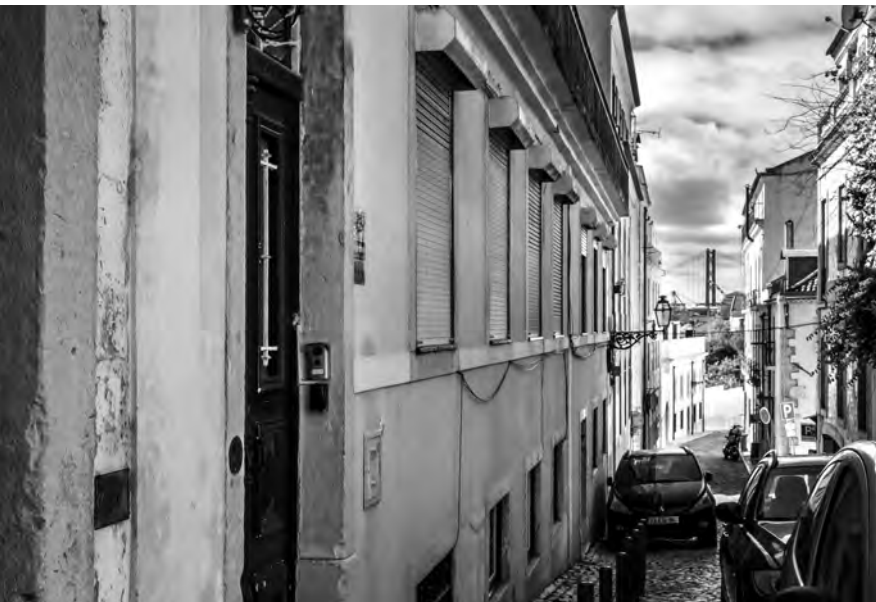
— Casa da travessa do Convento das Bernardas, 2024.
