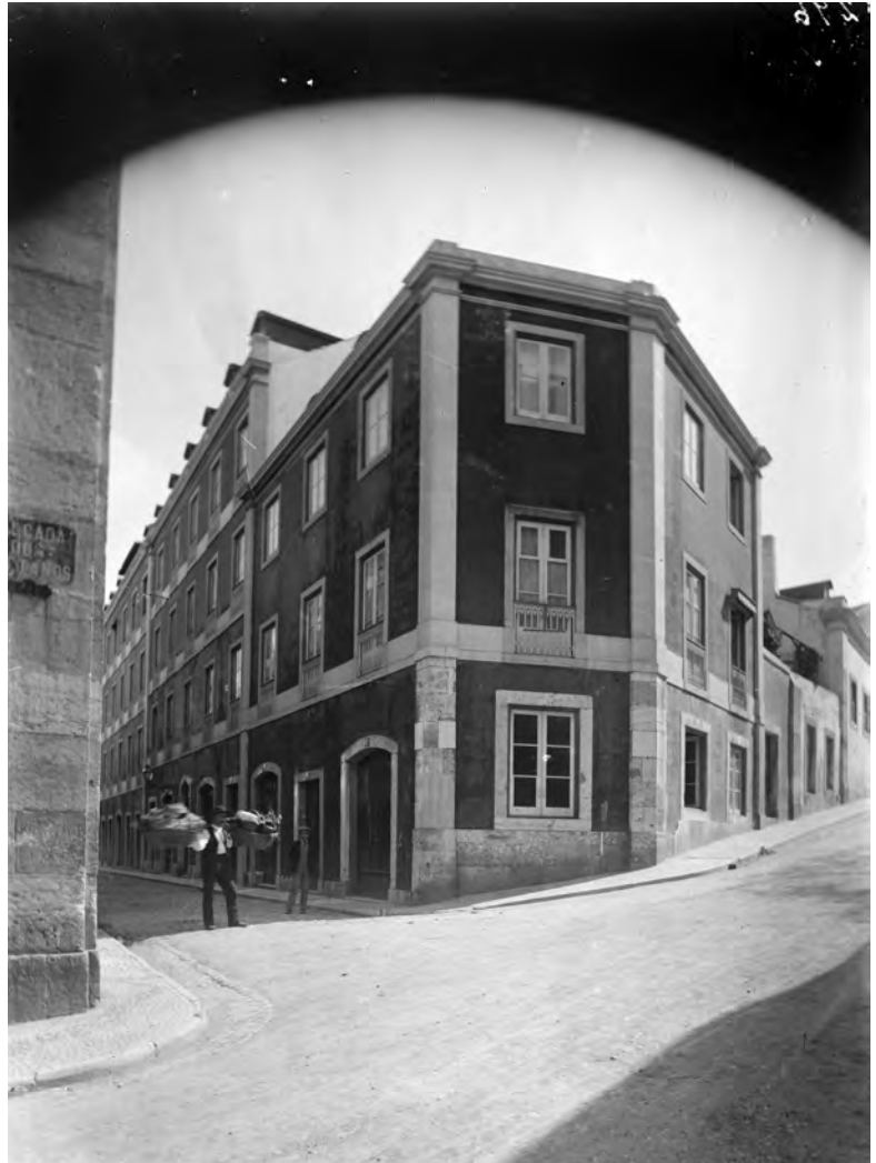
— Casa da rua Nova do Loureiro (3.º prédio da esquerda), [1898-1908].
