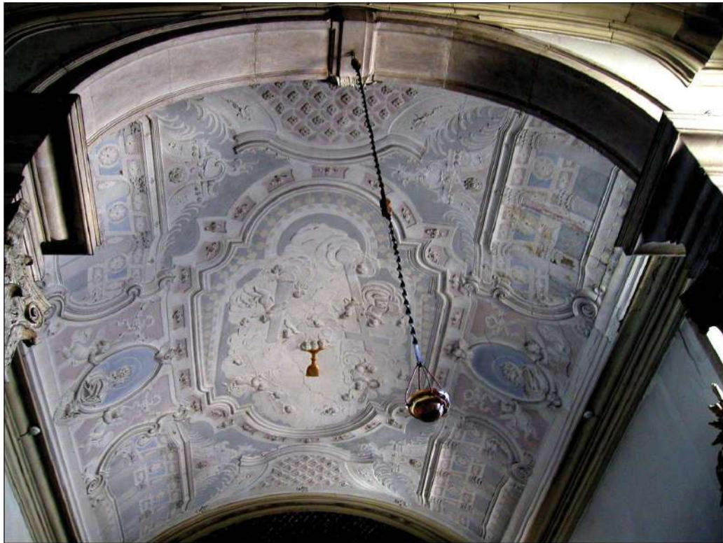
Fig. 6 – Capela da Via Sacra, anexa ao palácio do desembargador Alexandre de Sousa e Meneses, c. 1752. No teto da nave, uma elaborada quadratura, em estuque relevado e pintura, sugere parapeitos com rasgamentos centrais rodeados por plintos, balaustradas e colunatas perspectivadas. Domina a linguagem da regência francesa.
